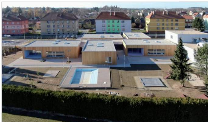
Obr. 1. Mateřskou školu Za Branou v Pacově navrhl Vyšehrad Atelier jako komplex několika pavilonů propojených jak mezi sebou, tak i s venkovními prostory. Komplexní řízení celého areálu s dálkovou správou realizovala Microcomp Plus na systému Tecomat Foxtrot.
